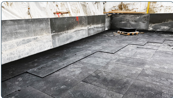
Mehrlagige Montage unter der Bodenplatte
