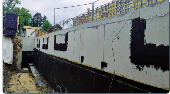
Montage an der Kellerwand
