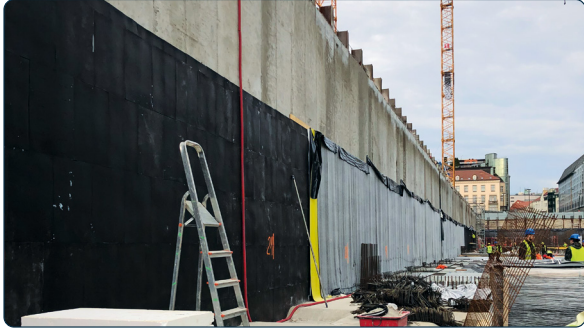
Montage an der Verbauwand
