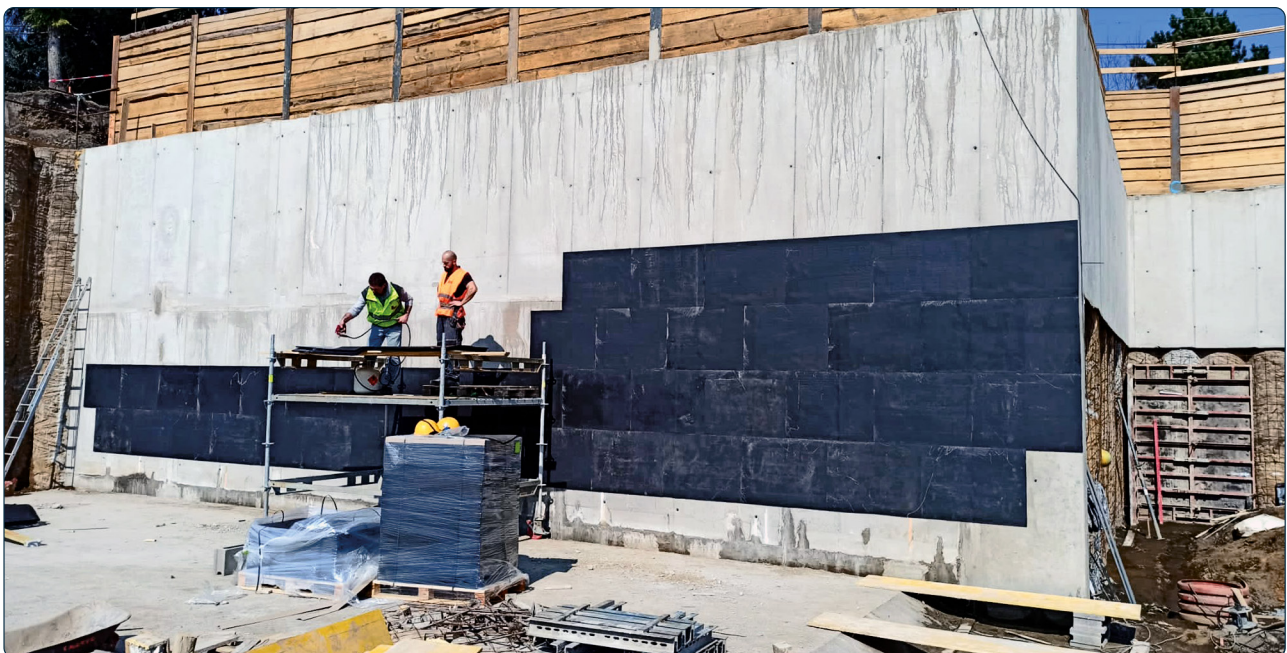
Montage an einer Stützwand
