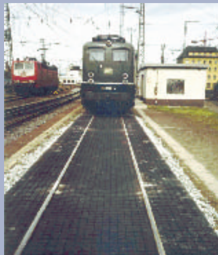
OIL-EX® auf einem Lokabstellplatz
