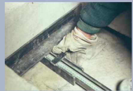
Bild 3: Positionierung der MFS Lager
