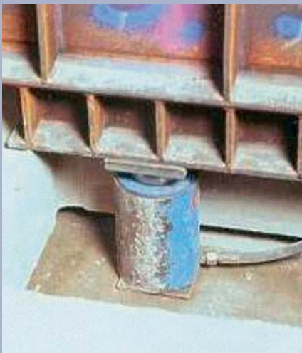
Bild 2: Hydraulische Hebevorrichtung
